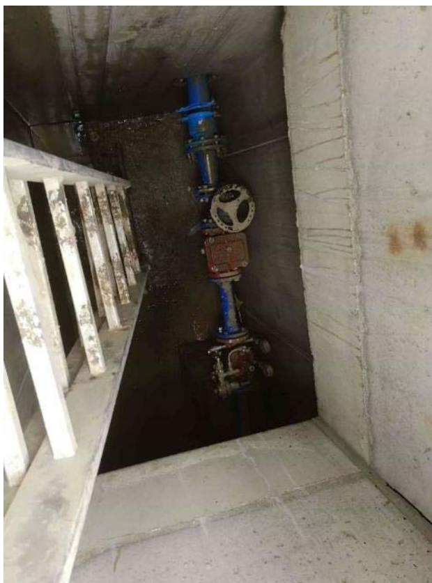
5/ Redukční ventil v redukční šachtě na vodovodu SO03
